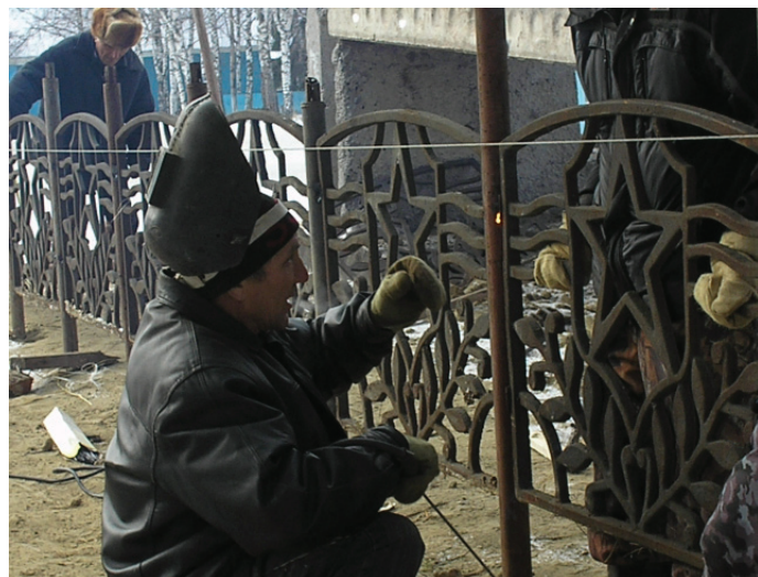
Идет возведение оградки памятника труженикам тыла
