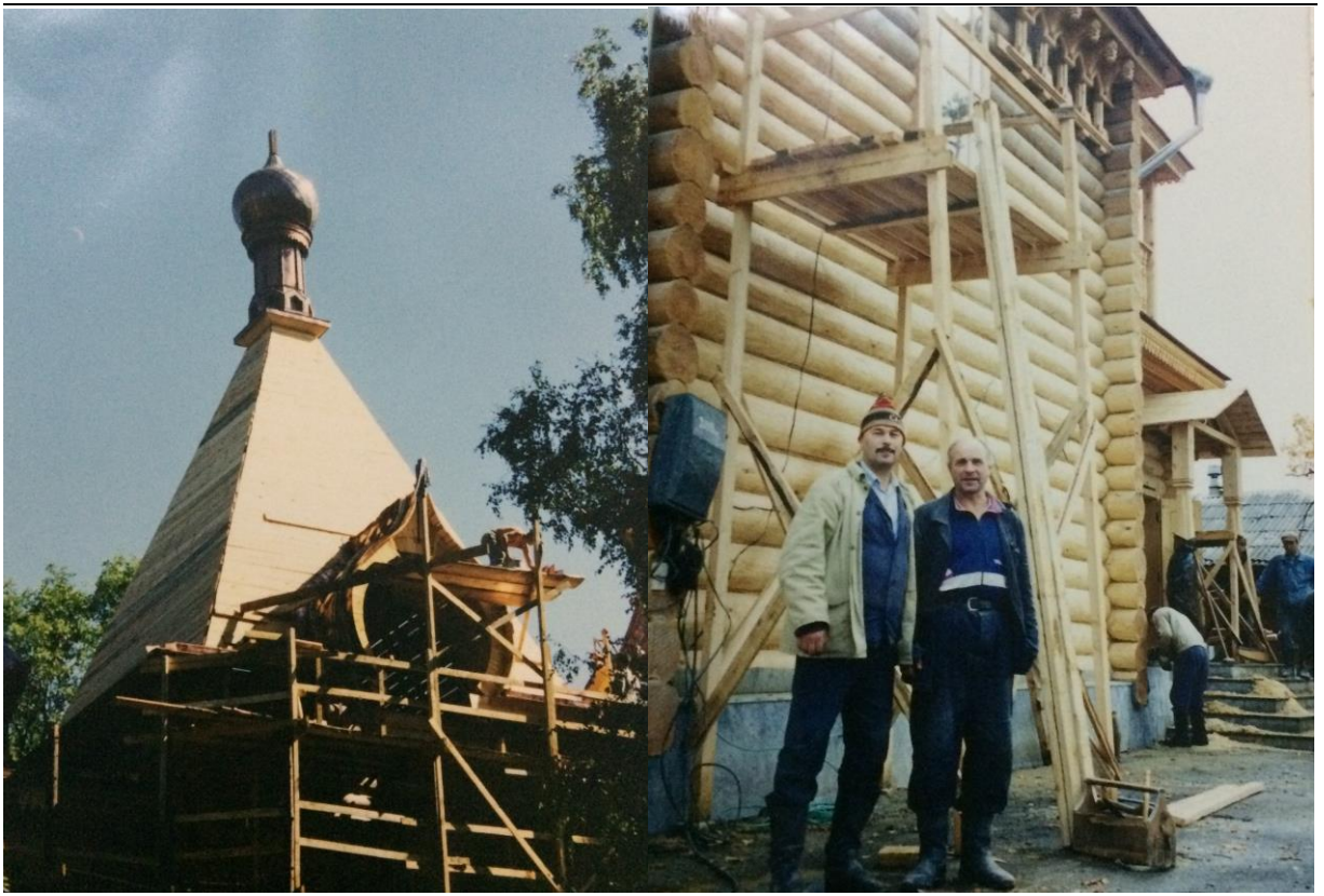
Строительство храма-часовни Александра Невского, 2001г.
