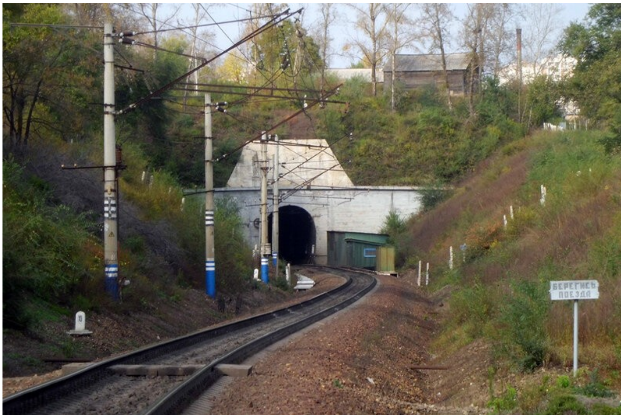
Вид восточного портала тоннеля.
