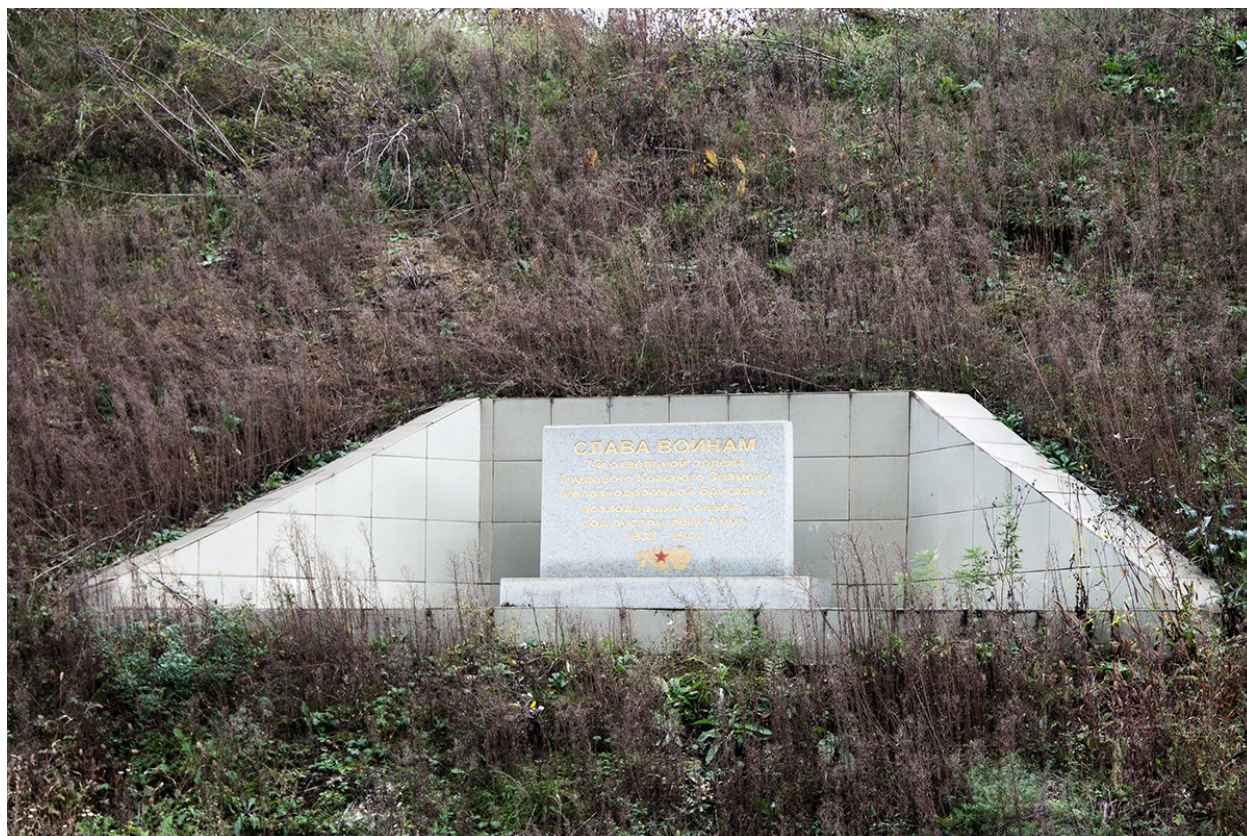
Гранитная плита в районе Восточного портала
